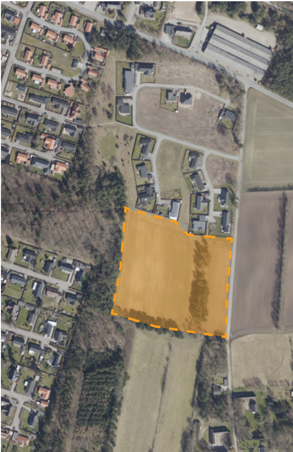
FOTO Luftfoto | Projektområdet i de eksisterende forhold
