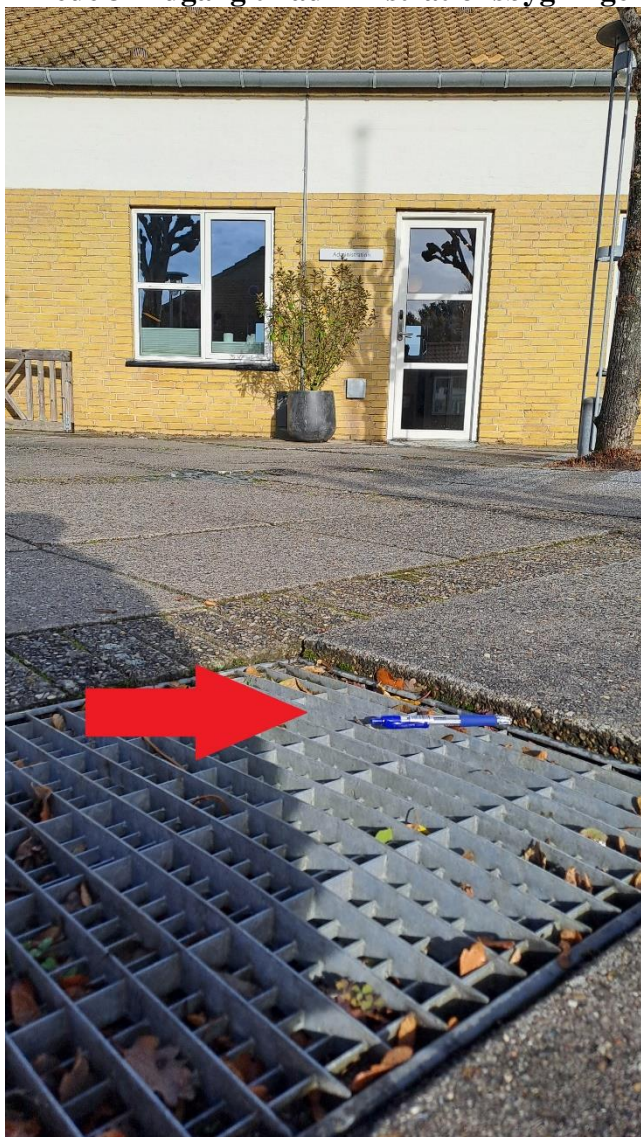
Nedsunken rist ved administrationsbygningen, hvor der færdes ansatte.
