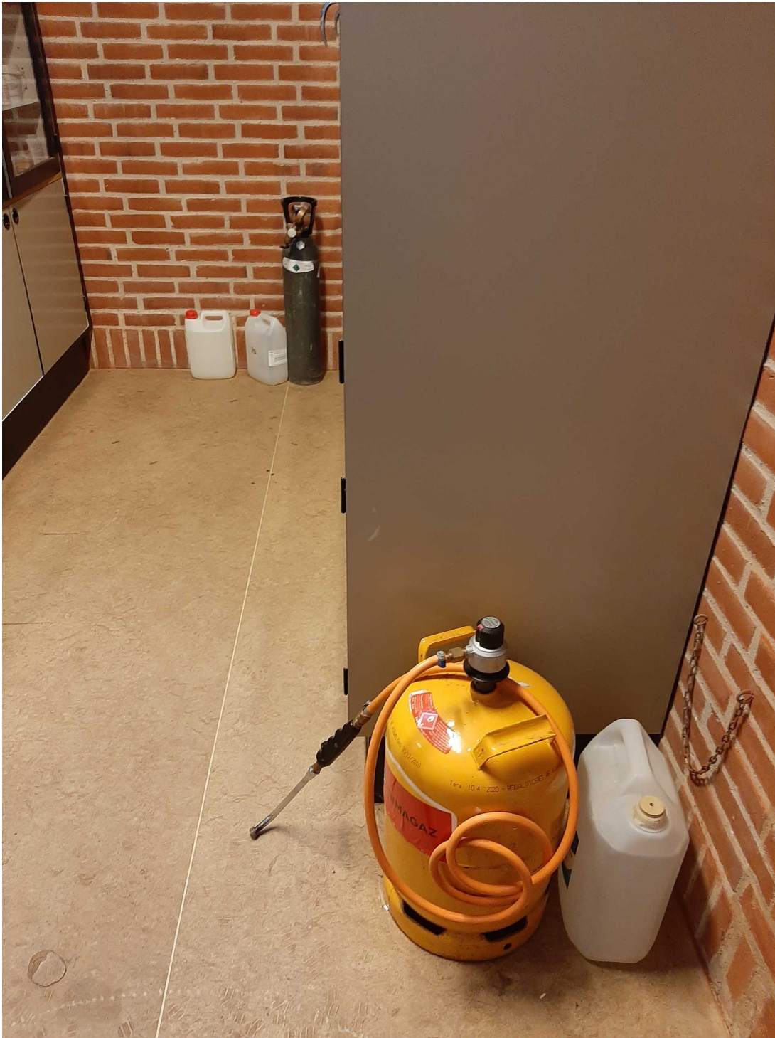
Trykbærende flasker ikke sikret mod væltning.
