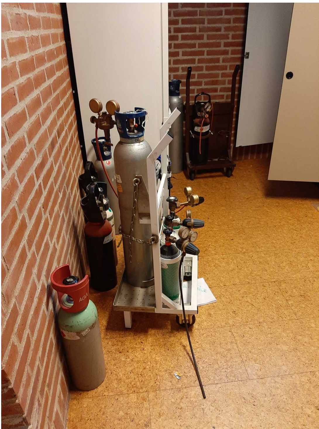
Trykbærende flasker ikke sikret mod væltning.
